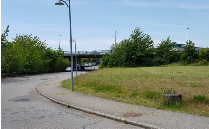
Molestien og viadukten under Bådehavnsgade.
