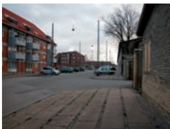
Ragnildgade set mod syd med skråparkering, boligbebyggelse og KTK-grundens bygninger.
