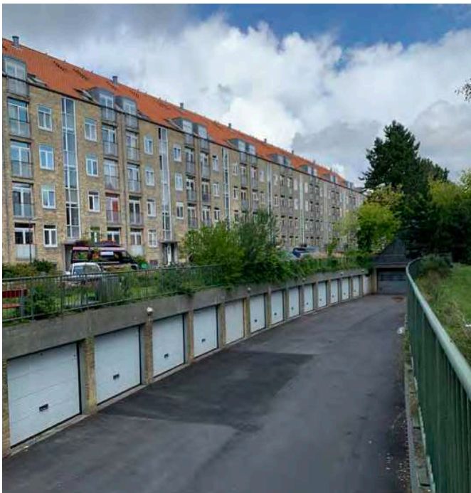
Parkeringsanlæg i Bispeparken
