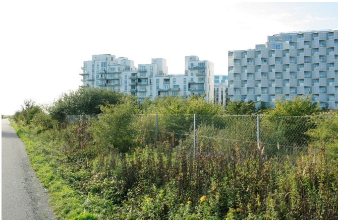
Nuværende hegn, grøft og beplantning langs sti på fælledsiden med de eksisterende bygninger i Ørestad Syd i baggrunden.
