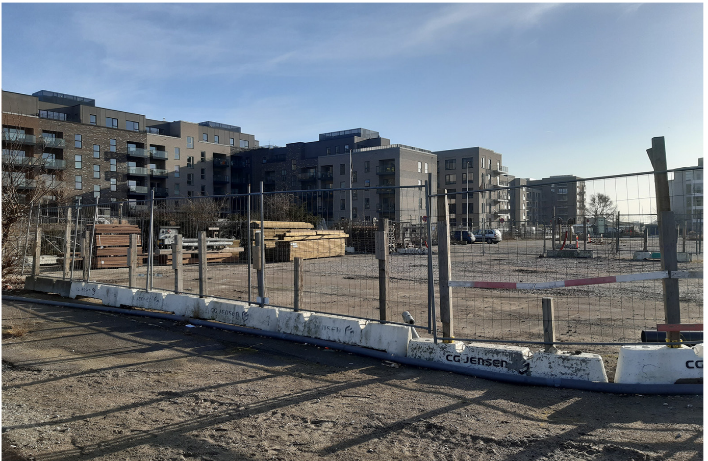
Byggegrund for byggefelt Q (syd) set mod nordøst.
