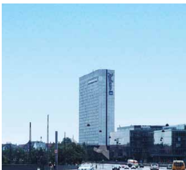
Eksisterende forhold set fra Langebro.
