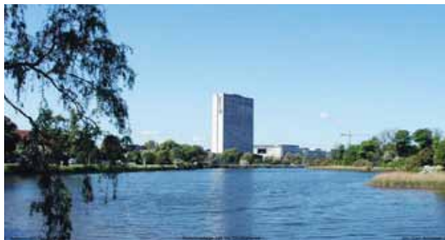
Eksisterende forhold set fra Stadsgraven.
