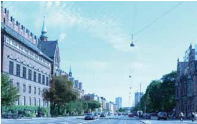
Eksisterende forhold set fra H.C. Andersens Boulevard.
