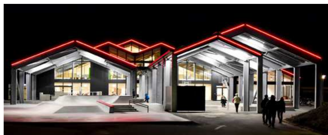
Overdækket udeareal og en åben facade. Forum Faaborg. Projekt af Keingart
