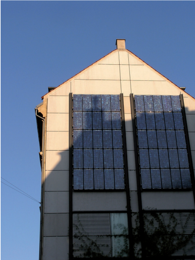
Solceller på gavl - Hedebygade-karreen
