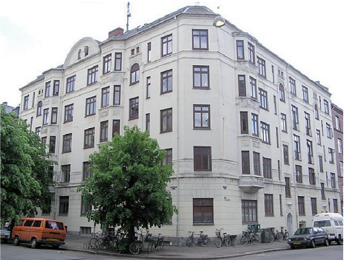
P.D. Løvs Allé 11-13/Thorsgade 64-66 for renovering af klima skærmen. Der er ydet støtte til tag og istandsættelse af vinduer på både gade- og gårdfacade.
