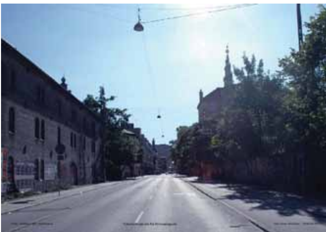
Eksisterende forhold set fra Prinsessegade.
