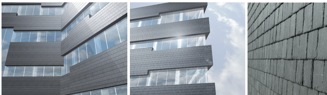
Forslag til facademateriale: skiferplader mål (30X30cm) på klink.
