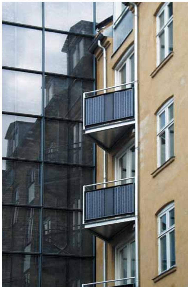
Eksempel på anvendelse af solenergi på gavl og altaner
