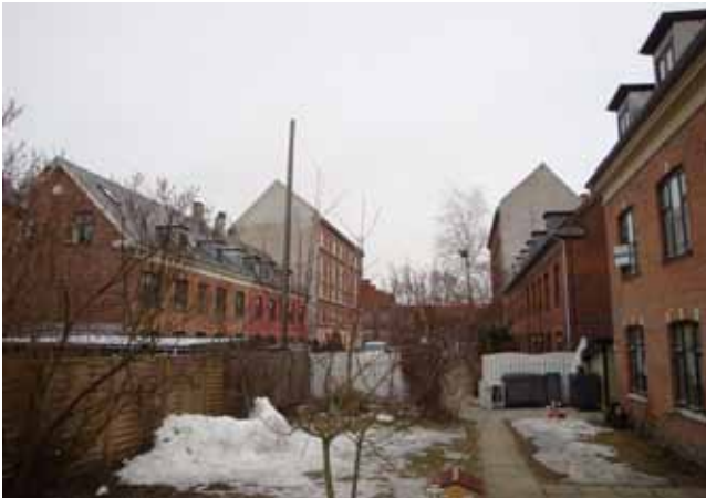
Byggeforeningshuse på Nordre Røse Vej opført i perioden 1900 - 1910
