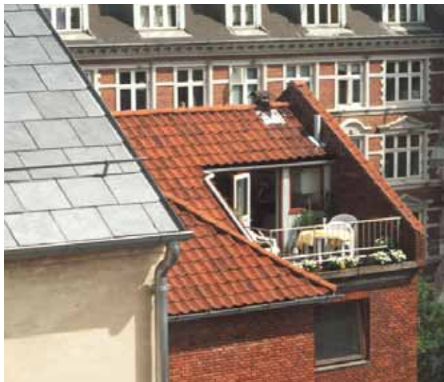
Eksempel på tagterrasse indbygget i tagfladen hvor værnet ligger bag den skrå tagflades afskæring.
