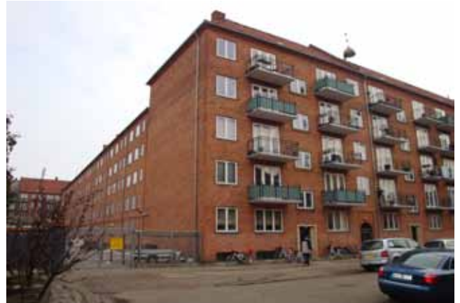
Karrébebyggelsen "KAB Søndergården" ved Strickersvej, Middelgrundsvej og Kirkegårdsvej fra 1930
