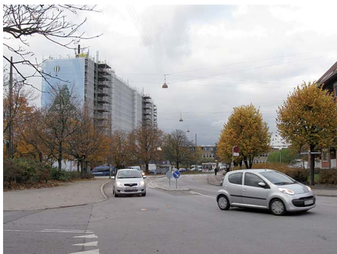
Kollektivhuset ved Hans Knudsens Plads
