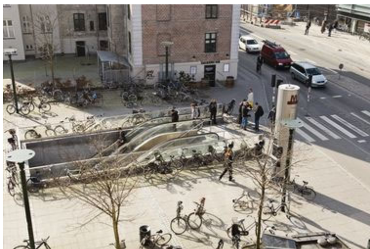
Figur 4.2 Det overjordiske anlæg ved Fasanvej Metrostation. Stationsforpladserne for Cityringens stationer vil blive udformet efter tilsvarende principper under hensyntagen til de lokale forhold ved hver station.
