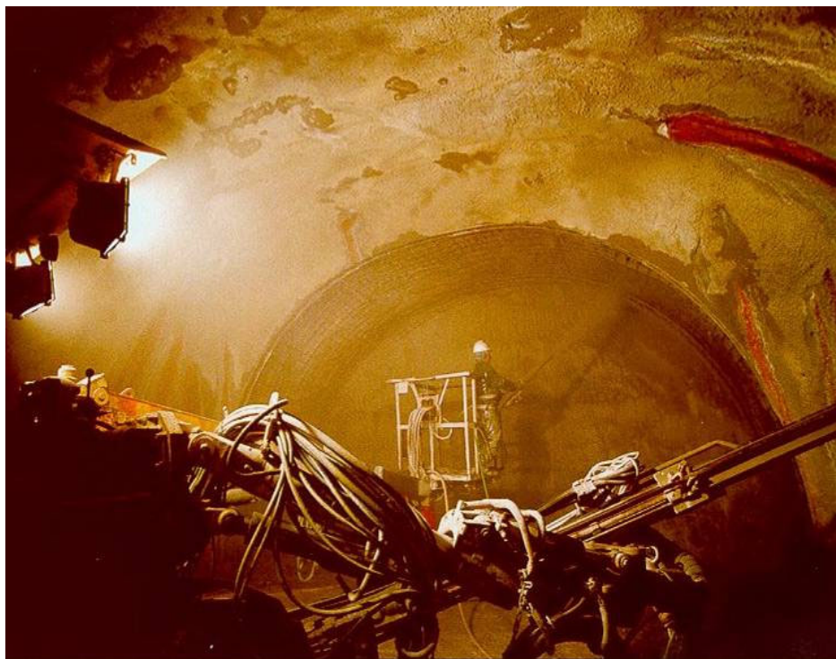
Figur 4.10 Påføring af sprøjtebeton i kaverne, Københavns Metro.
