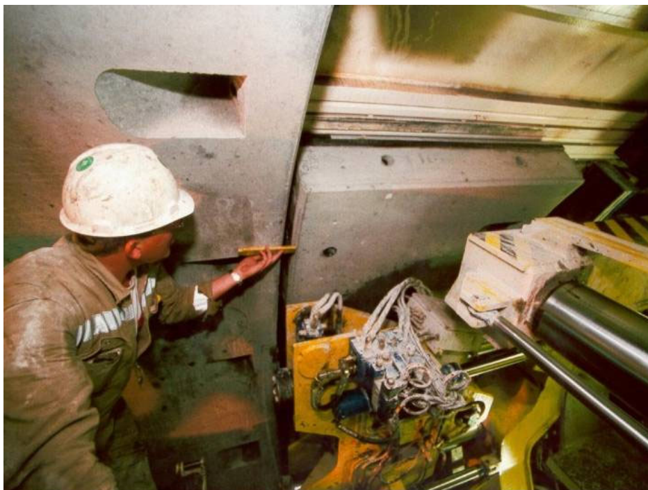
Figur 4.5 Montering af betonelementer i tunnel, Københavns Metro.
