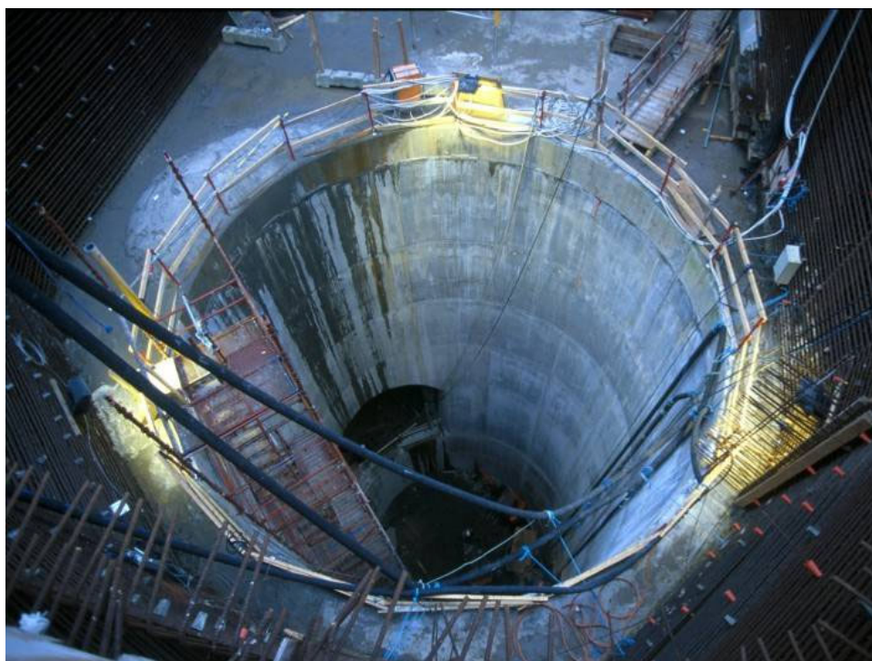
Figur 4.11 Skakt foret med beton på indersiden for opnåelse af jævn og tæt overflade, Københavns Metro.
