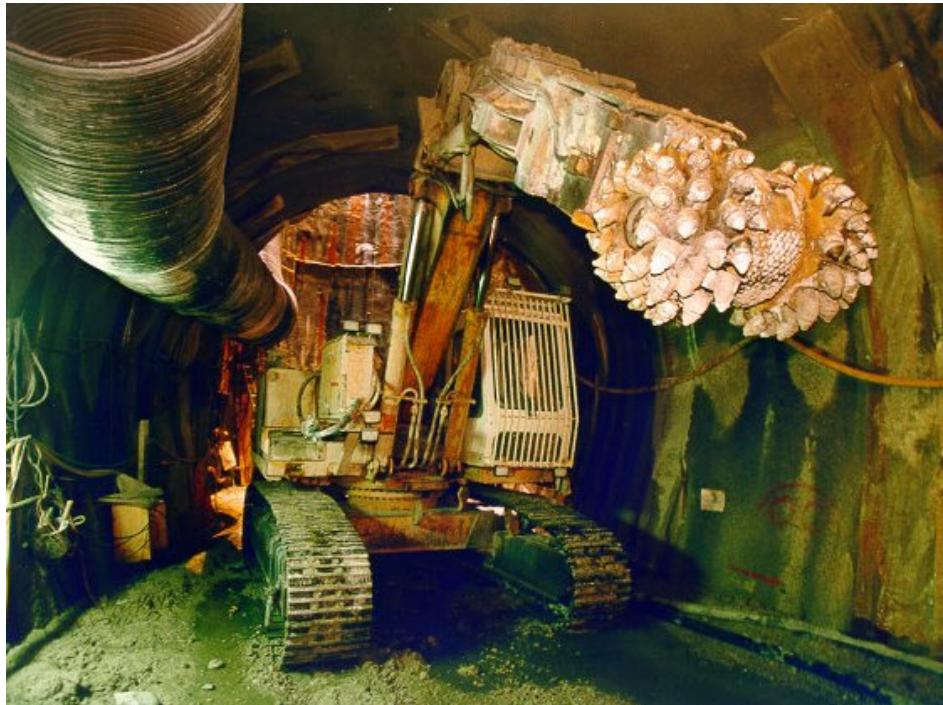
Figur 4.8 Fræsemaskine "roadheader" til udgravning i kalkundergrund, Københavns Metro
