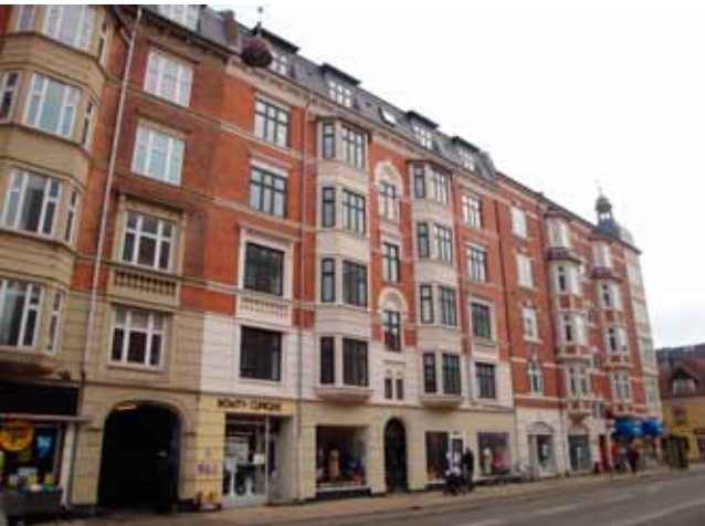
Amagerbrogade 125-133 opført 1904-1907 har høj bevaringsværdi
