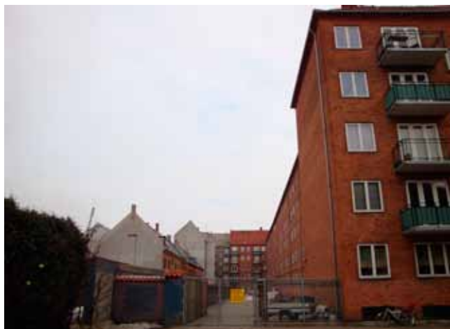
Børnekulturhuset skal opføres her mellem gavlene på disse bygninger.
