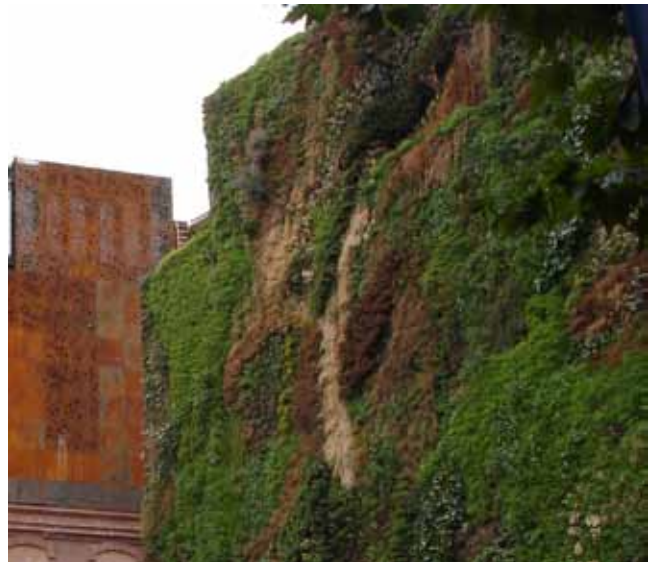
Eksempel på varmeisolerende og begrønnet gavl.
