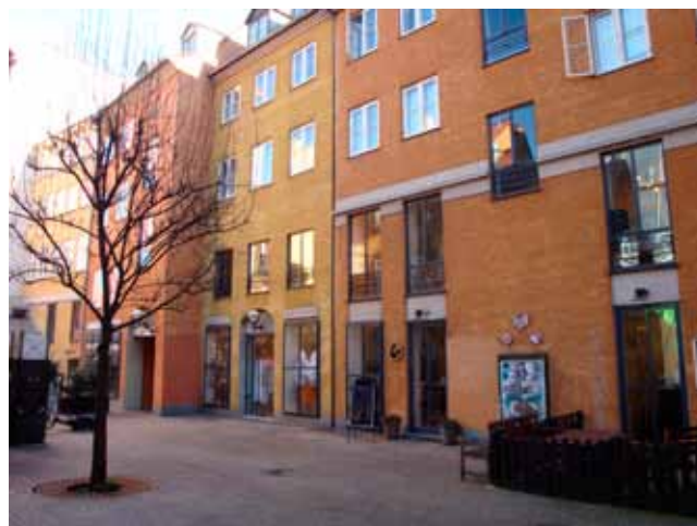
Butiksfacade mod gården Store Kongensgade 5B-19B.
