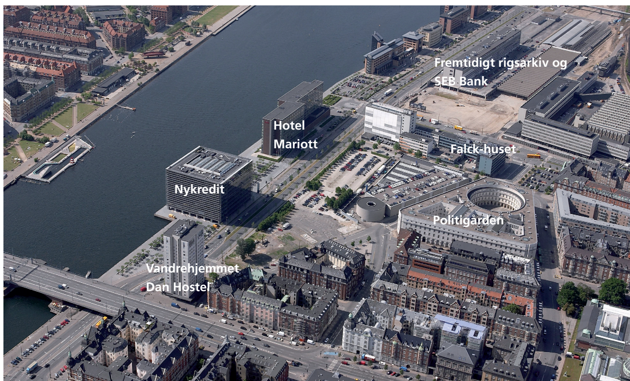
Luffoto af lokalplanområdet omgivet af ældre karrébebyggelse, og større eksisterende og fremtidige bygningsvolumener.
