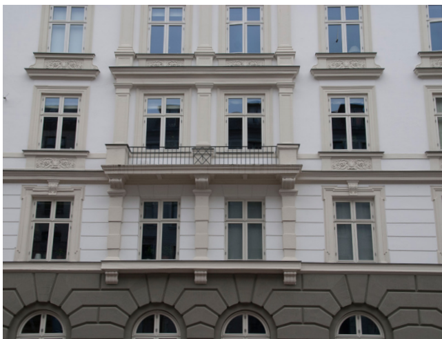
Foto 19. Altan, der spænder over flere vinduesfag, kan i de fleste tilfælde være en mulighed. Den passende længde afhænger i hvert enkelt tilfælde af ejendommens facadearkitektur og beliggenhed.
