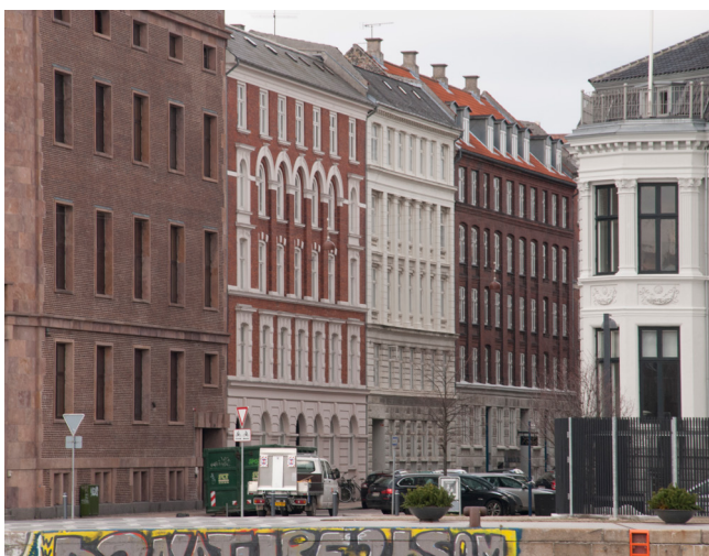
Foto 6. Facaderække med den klassiske opdeling med en under- og overfacade opdelt af gesimser. De forskellige facadebehandlinger, med enten blank mur eller pudsede facader, skaber en horisontal opdeling. Gesimserne understreger de vandrette linjer.
