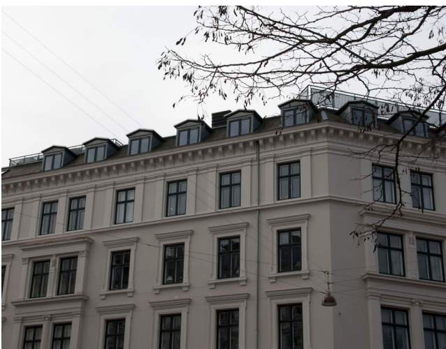
Foto 16. To tagterrasser placeret på den flade del af københavnertaget. Tagterrassen til højre er meget synlig, mens tagterrassen mod venstre er mere diskret placeret. Det er ønsket, at en tagterrasse ikke kan ses fra gadesiden.
