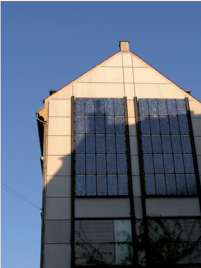
Solceller på gavl - Hedebygade-karreen
