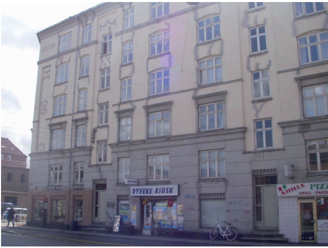
Kastrupvej 4-6 før byfornyelse
