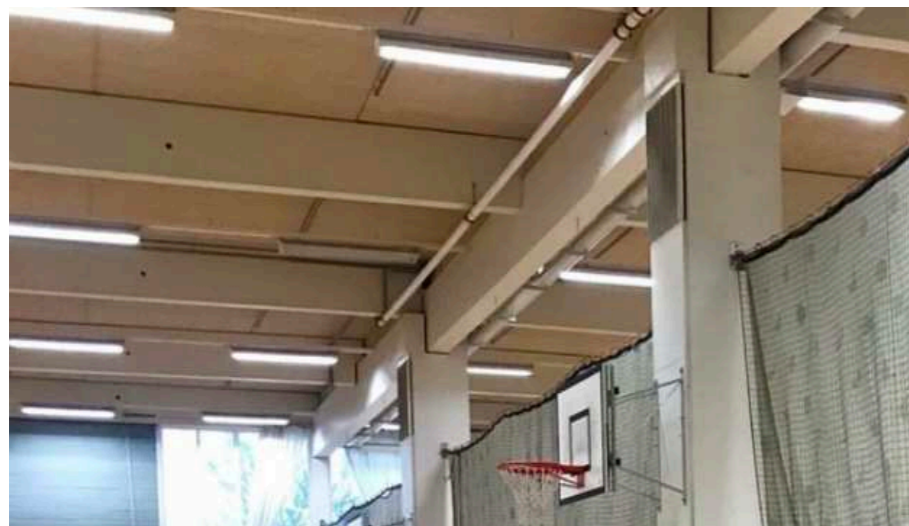
Foto af den eksisterende hovedkonstruktion
