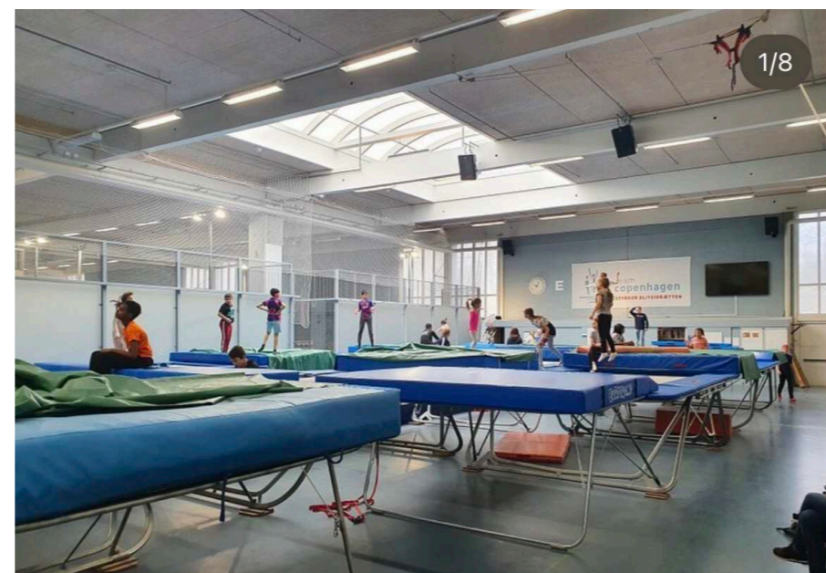
Trampolinhal med lokal forhøjning ved lyskuppel
