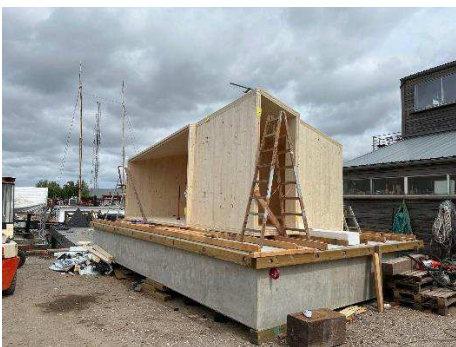
Saunahuset monteres, Juni 2024 – Krohns værft, Slusen, Kbh
