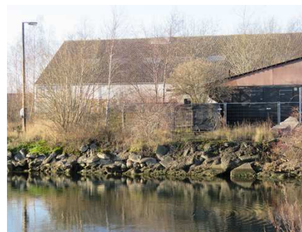
Billedet viser lokalplanområdets kant mod Skudehavnen. Kanten mod vandet består af opfyld bl.a. gamle betonstykker og har varierende beplantning, som er fremkommet naturligt.
