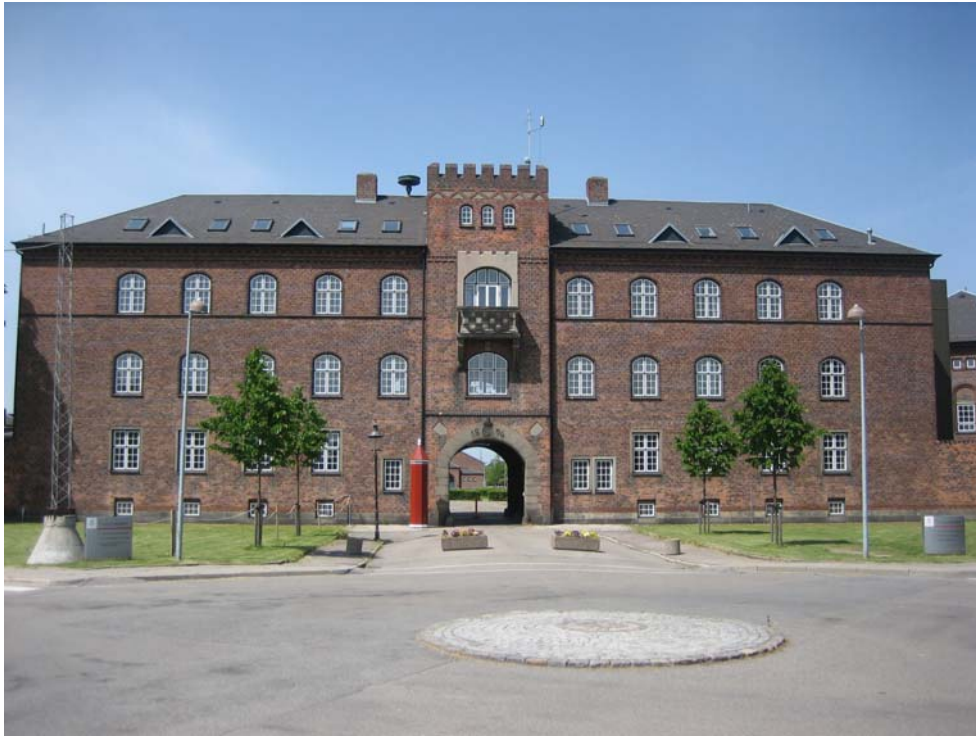
Figur 5.15 Kasernens hovedbygning. Tunnellen vil passere under gavlen til venstre
