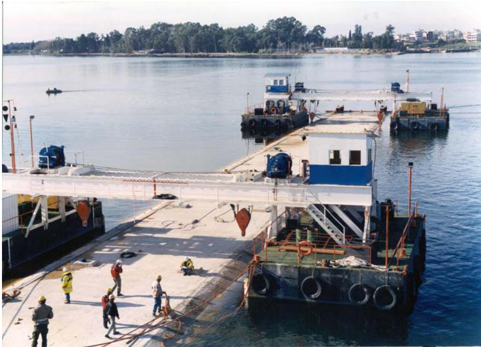
Figur 6.4 Preveza-Aktio tunnel Grækenland – Udflåding af tunnelement
