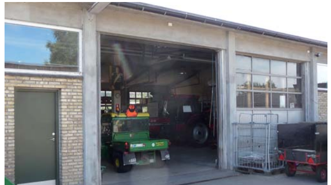
Garagebygning vest for bevaringsværdig bebyggelse, bygning 94, nedrives.
