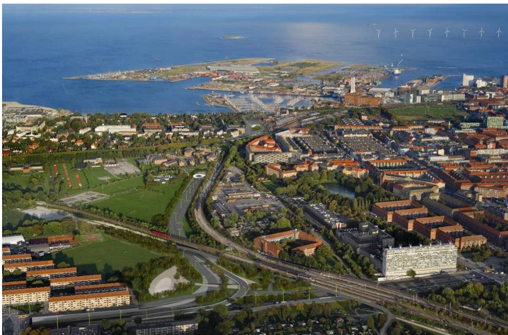
Figur 2.5 Visualisering af projektområdet, hvor et udvalgt tilslutningsanlæg ved Helsingørmotorvejen ses i forgrunden og Svanemøllebugten ses i baggrunden ( Schönherr Landskab ).
