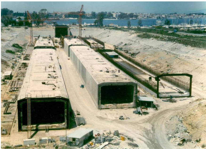
Figur 6.15 Preveza-Aktio tunnel i Grækenland – Bygning af tunnelelementer i separat dok
