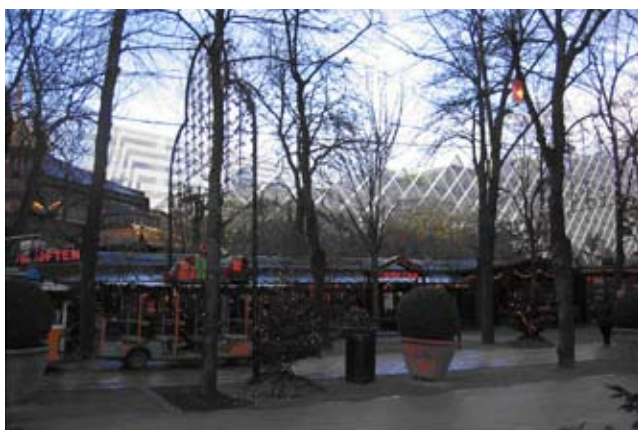
Groften - efter. Nedtrapping af facaden mod Pantomimeteatret.
