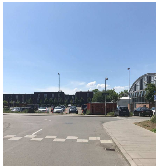
Billedet viser nordskellet af matr.nr. 650bt, Christianshavns Kvarter, hvor der etableres botilbud til unge med autisme. I baggrunden ses rækkehusbebyggelse.
