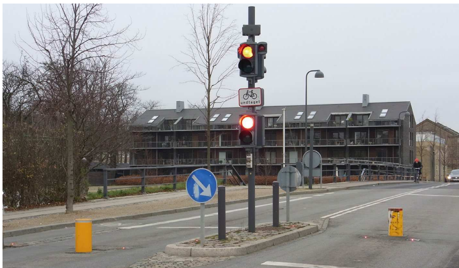
Den mekaniske bussluse syd for Frederiksholmsbroen.
