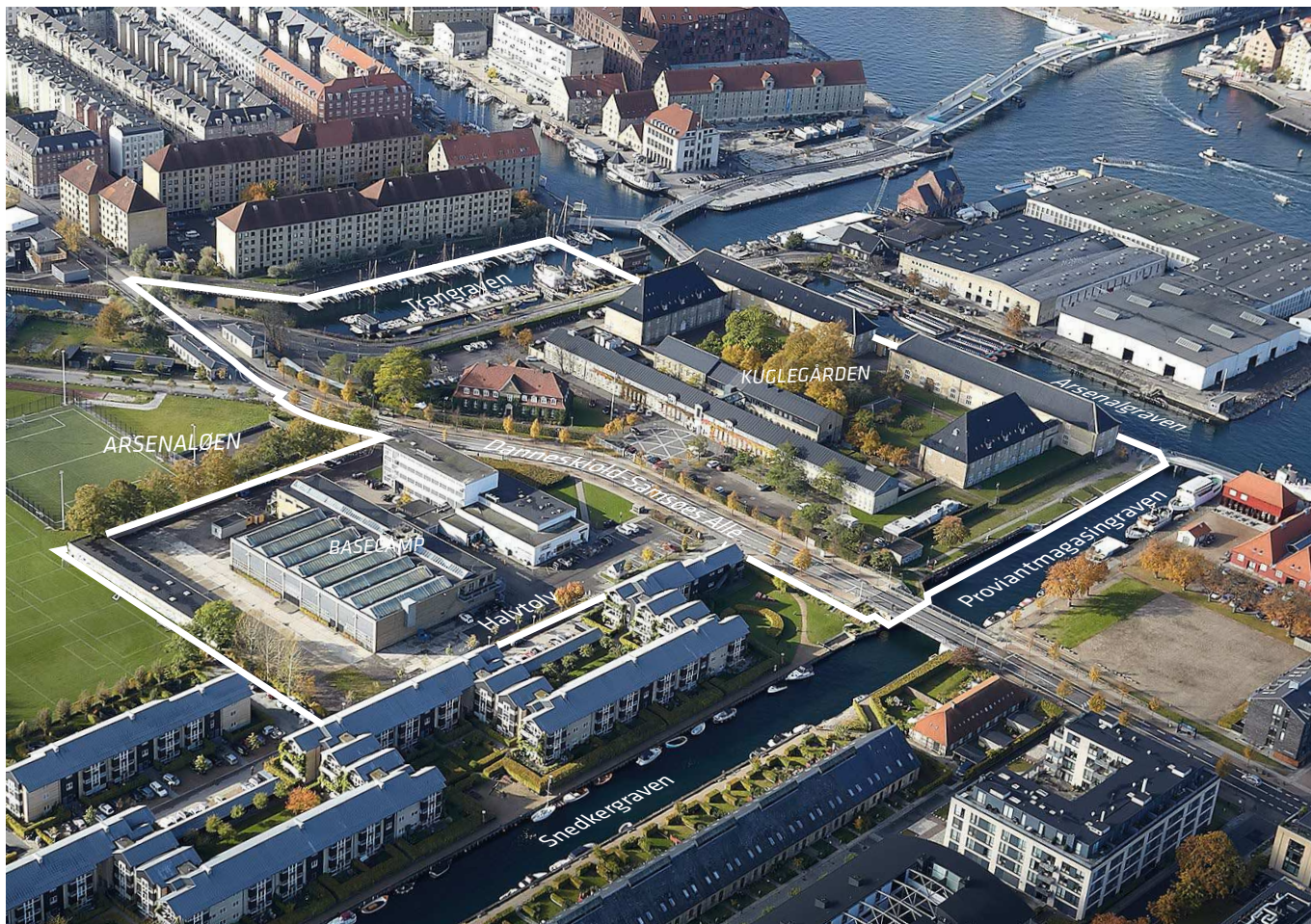
Skråfoto af lokalplantillægsområdet. JW Luftfoto, oktober 2016.
