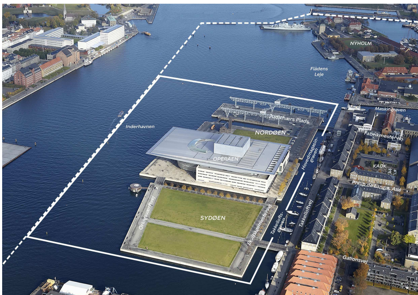
Dokøen set mod nord. Lokalplanområdet er indtegnet med hvid linje, og grænsen for lokalplan 331 er indtegnet med stiplede linje. Dokøen består af Nordøen, Operaen og Sydøen. De vigtigste gader, pladser og bygninger er navngivet. Foto: J.W. Luftfoto, 2016.
