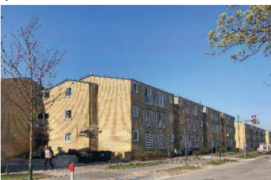
Facade med ny tagetage på Ruten, set mod vest.
