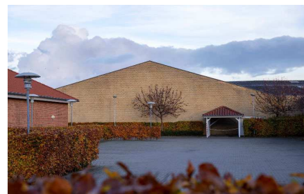
Jorisvej 11a – Gavl fra fabrikshal opført i 1969.
