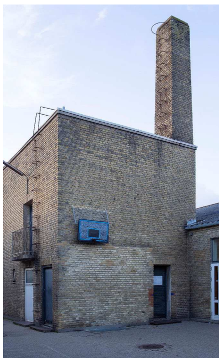
Engvej 143 - Kedelhus opført i 1961.
