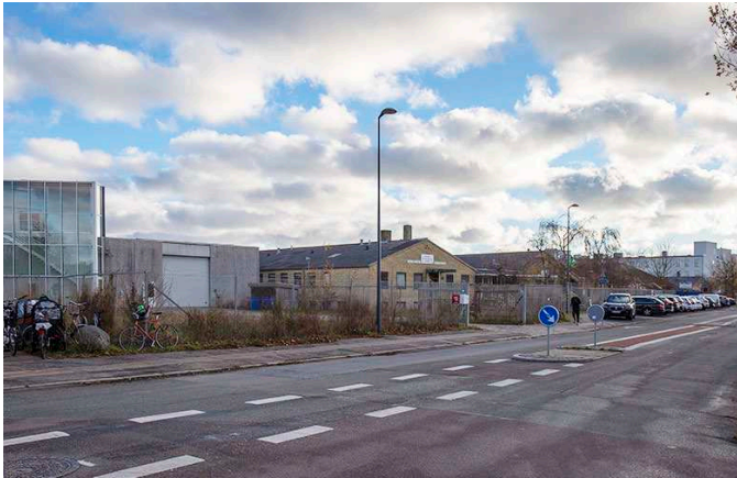
Lokalplanområdet vist fra Engvej i den nordlige ende.
