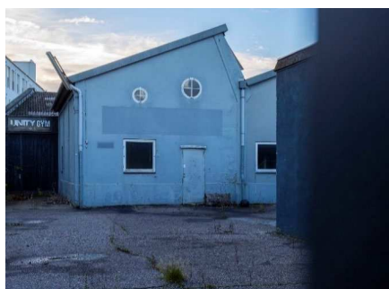
Jorisvej 11 - Del af fabriksbygning med shedtag opført i 1958.
