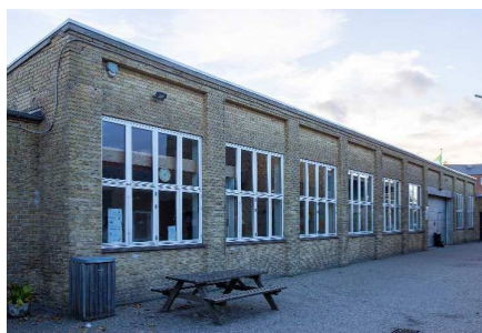
Engvej 145 - Fabriksbygning opført i 1961.
