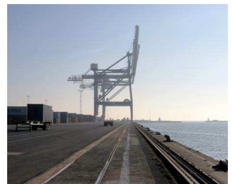
Kranspor og fortøjningspullerter langs den sydlige kajkant.
