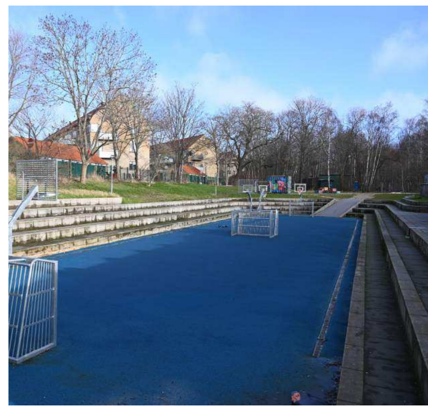
Multibane i skybrudssikringsbassin
