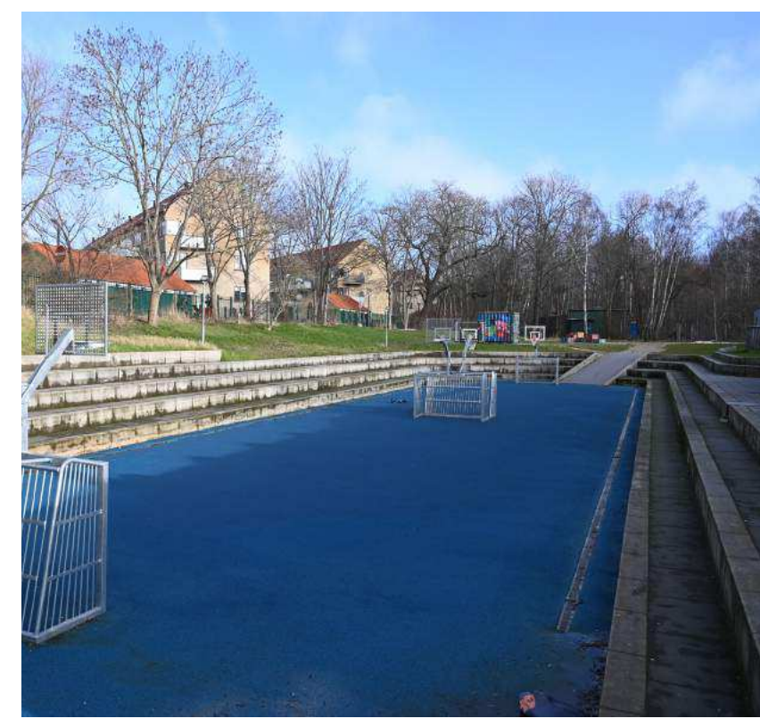
Multibane i skybrudssikringsbassin
