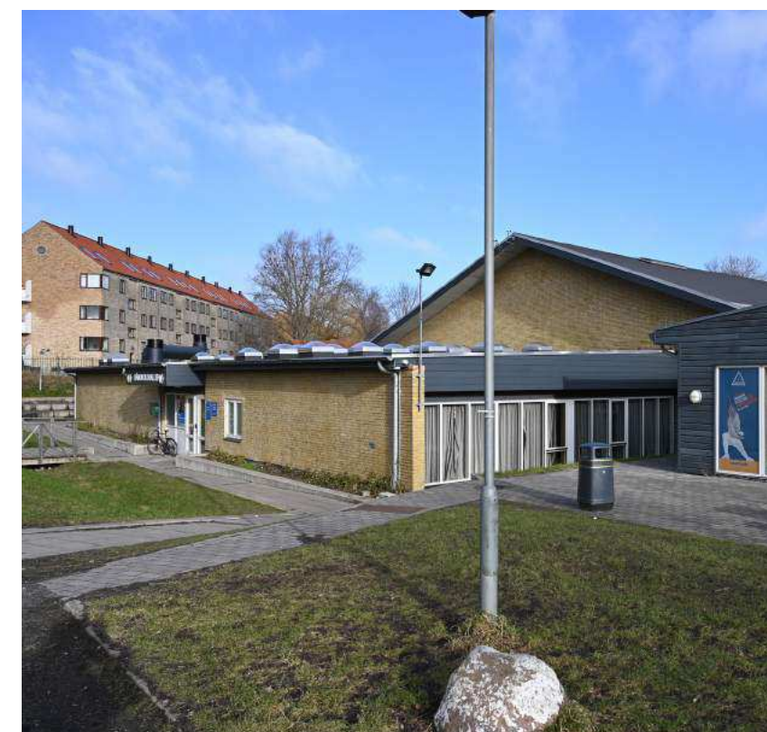
Håndboldhal med lav forbygning
