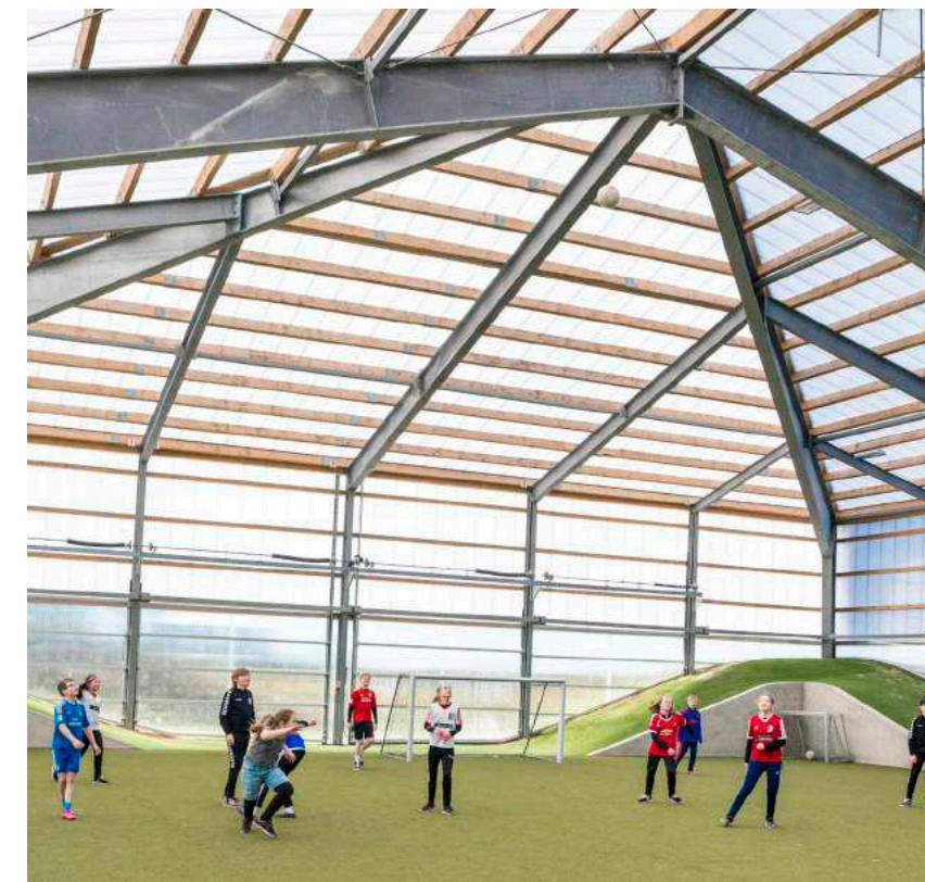
Bakkerne kan trækkes ind under overdækningerne
