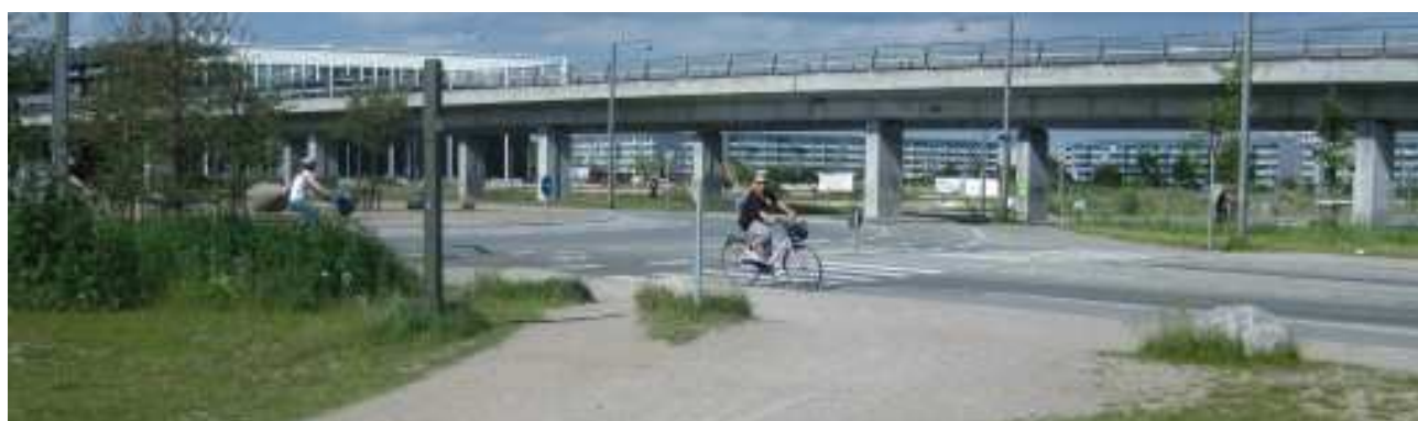
Foto 4: Rundkørslen ved Grønjordsvej set fra Amager Fælled stien
