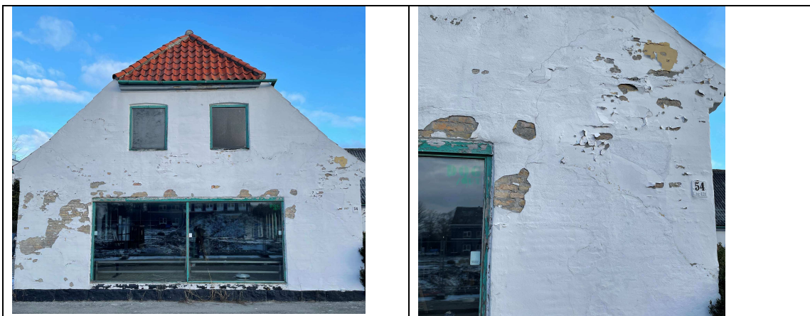
Billede 3 – Bygning 1 Sydlig gavl
