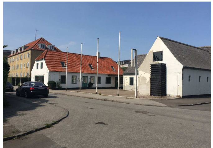
Den eksisterende bygning på Ulrik Birchs Allé 54 set fra Vatnavej. Bygningen er en gård fra 1853 og udpeges som bevaringsværdig.
