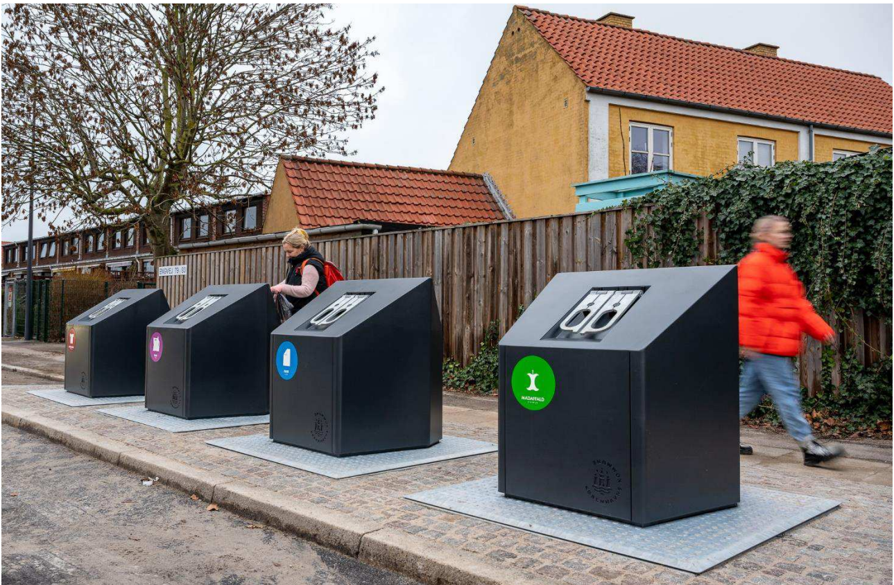
Sorteringspunkt i Amager Øst med fire nedgravede beholdere. Anlagt i januar 2023.
