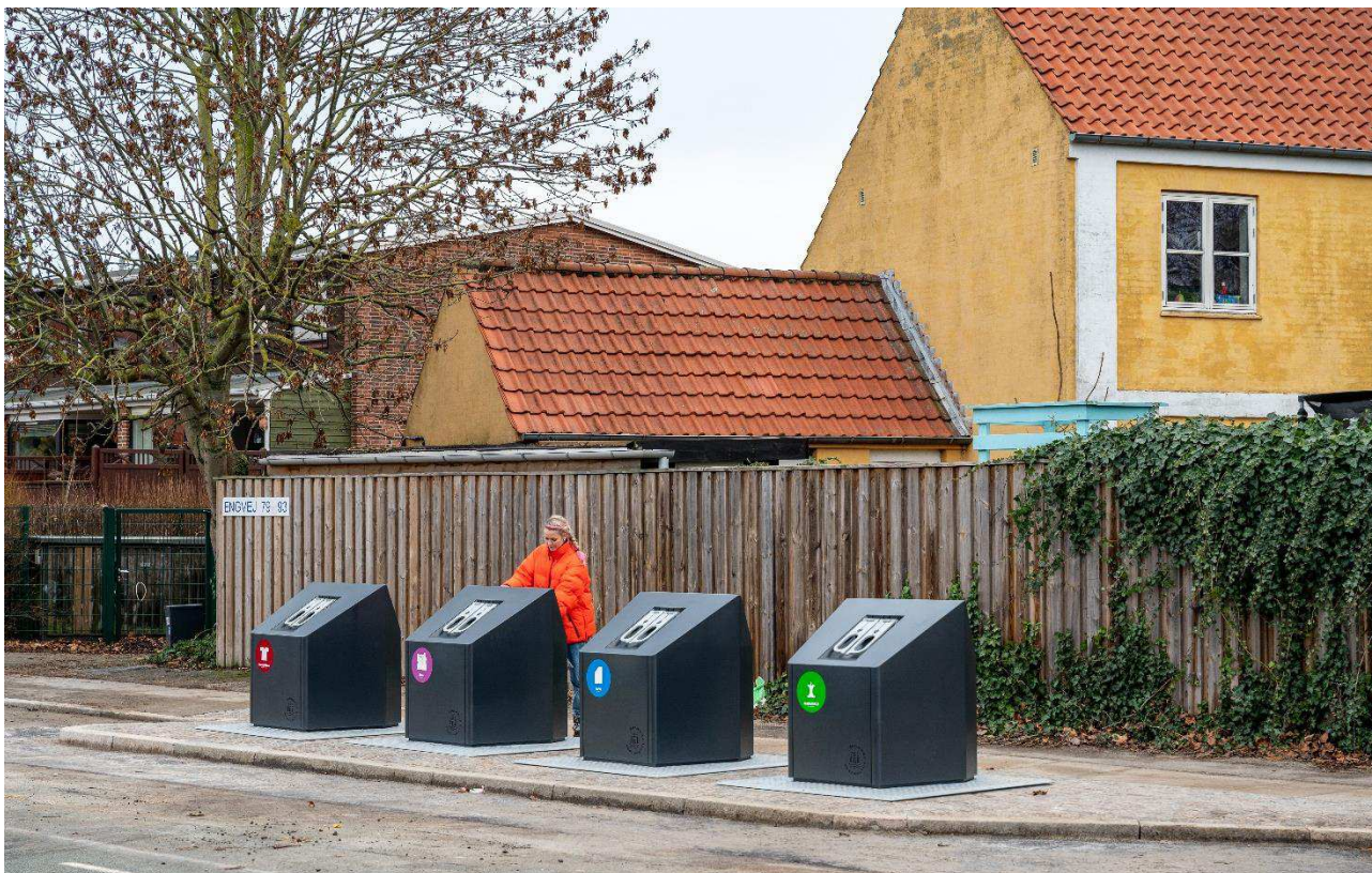
Eksempel på sorteringspunkt med fire nedgravede beholdere i Amager Øst.
