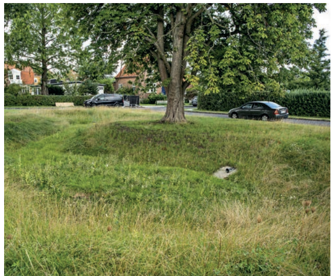
↑ Regnbed samt bassin på C.J. Frandsensvej (foto HOFOR)
