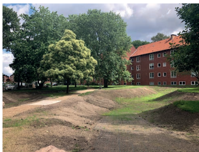
↑ Anlægsarbejder i Husum Vænge
