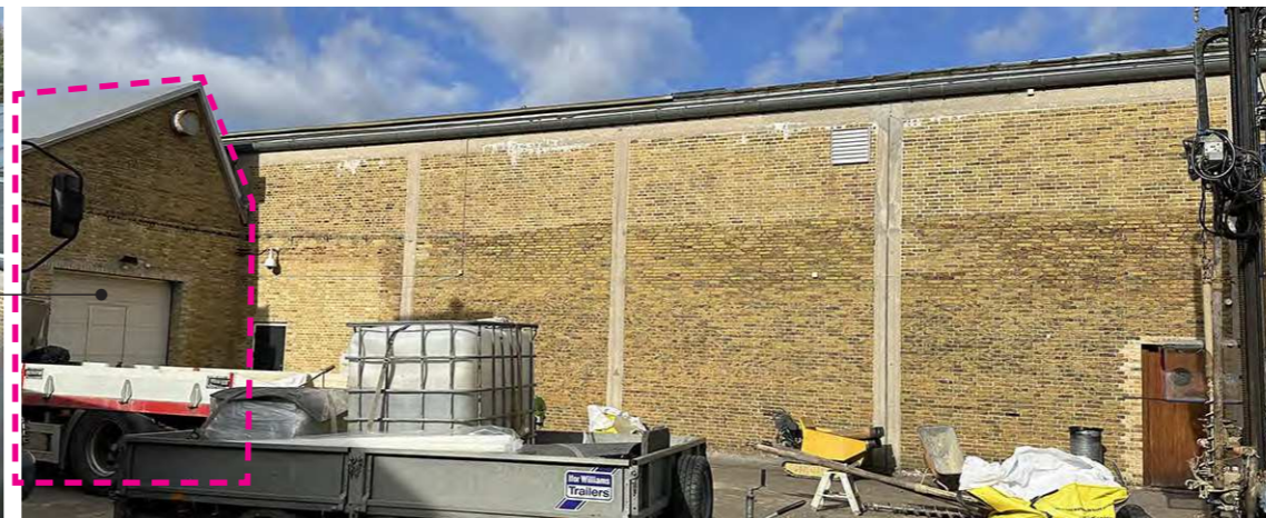
Gårdfacade mod syd
