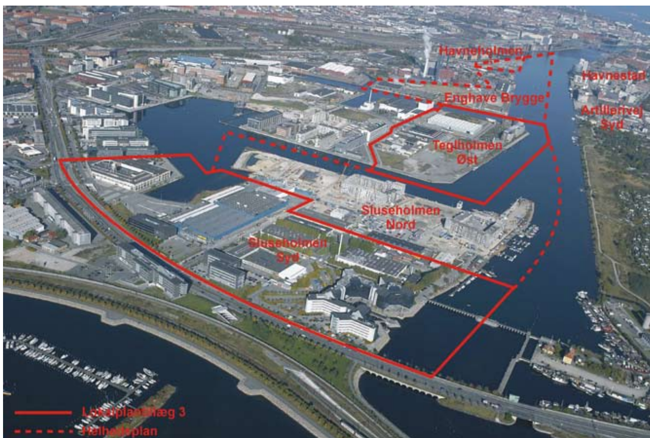
Luftfoto af lokalplanområdet set fra syd med afgrænsning af "Sluseholmen Syd" og "Teglnholmen Øst" samt området, der er omfattet af helhedsplanen. I forgrunden ses engros-supermarkedet Metro og Louis Poulsens produktionsområder. Langs Sjællandsbroen/Sydhavngade ses Sluseholmen nr. 8 "Nauticon", der bl.a. udlejes til LM Ericsson og Skattecenter København, kontorbyggeriet Sluseholmen nr. 2, der er opført i 2003 og til venstre i billedet den nu nedrevne Fordbygning. Midt for ved Teglværksløbet ses karreerne på Sluseholmen Nord under opførelse. (JW Luftfoto oktober 2005).
