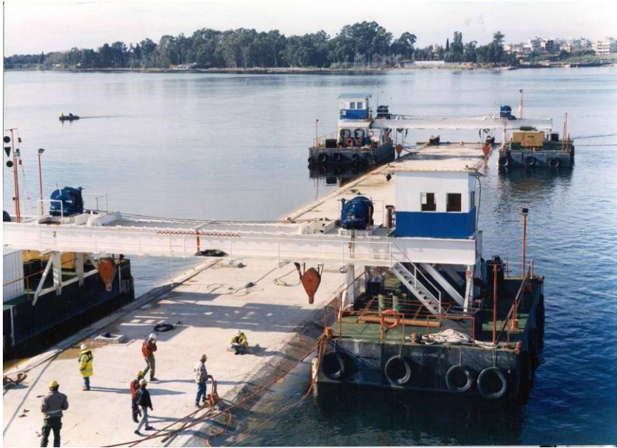
Figur 6.17 Preveza-Aktio tunnel Grækenland - Udflåding af tunnelement
