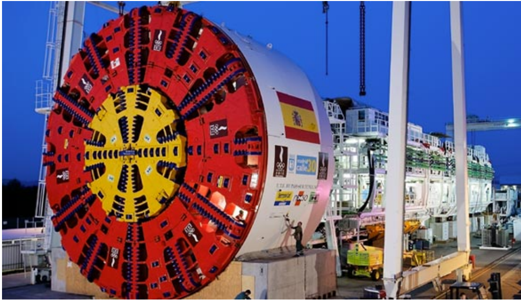
Figur 7.5 EPB tunnelboremaskine med diameter 15,2. Fra projekt M30 i Madrid.
