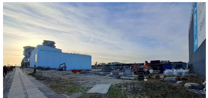
Her ses grunden fra Kalvebod Brygge, hvor man ser IKEAs gavl og de to kakustårne i baggrunden samt busterminalen til højre i billedet.
