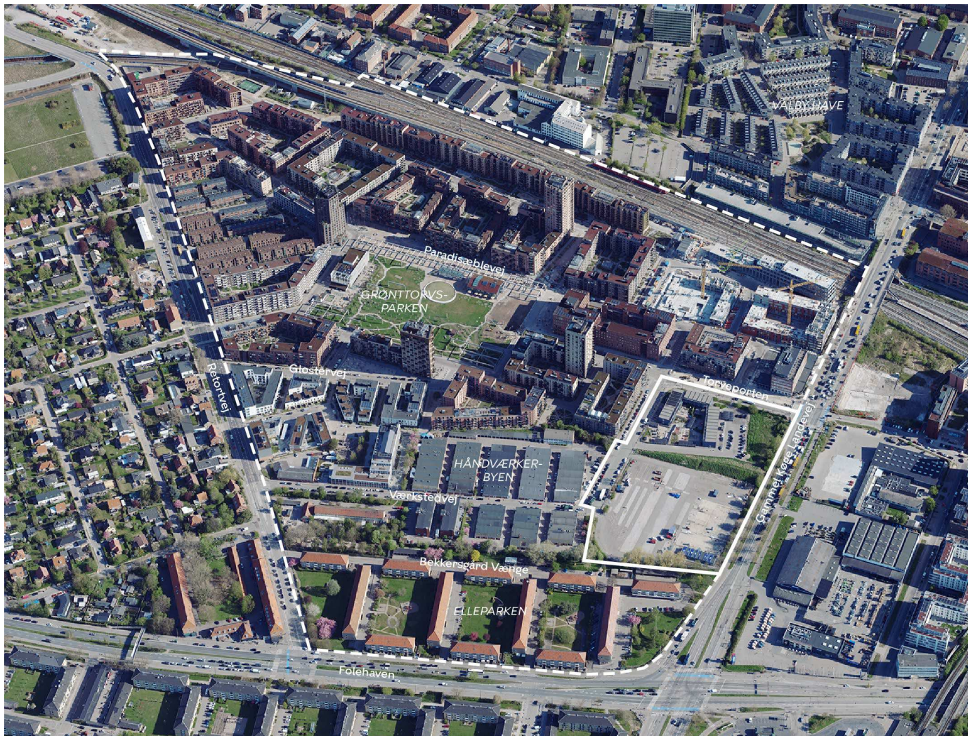
Området set mod nord. Lokalplantillægsområdet er indtegnet med hvid linje, lokalplan 462 er indtegnet med hvid, stiplede linje og de vigtigste gader, pladser og bygninger er navngivet. Luftfoto: SDFI, 2023.
