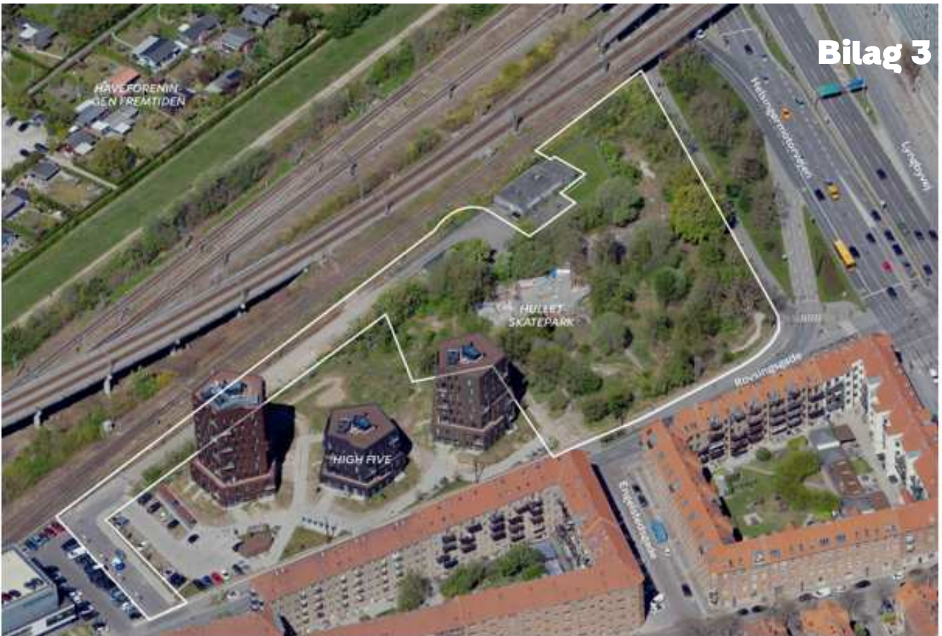
Området set mod nordøst. Lokalplanområdet er indtegnet med hvid linje, og de vigtigste gader, steder og bygninger er navngivet. Luftfoto: SDFI, 2023.
