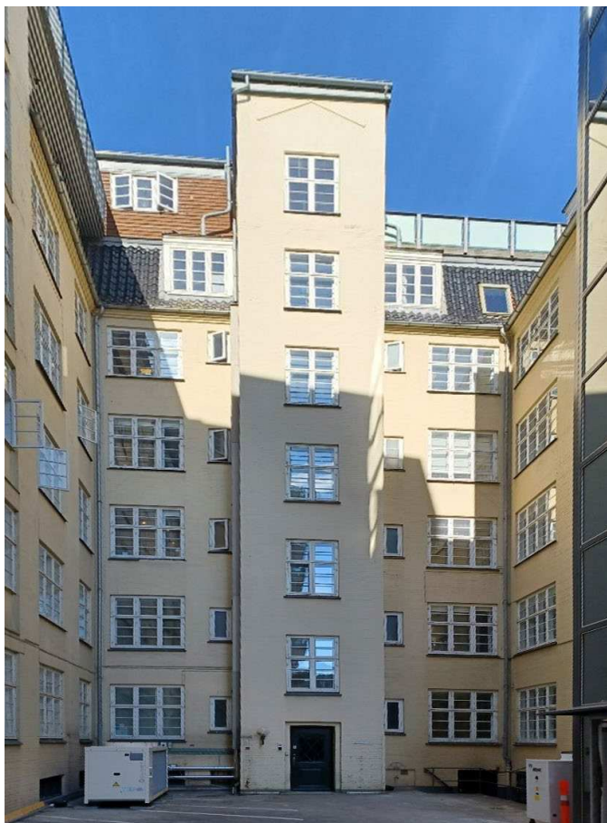
Mellemhusets facade set fra gårdrummet.
