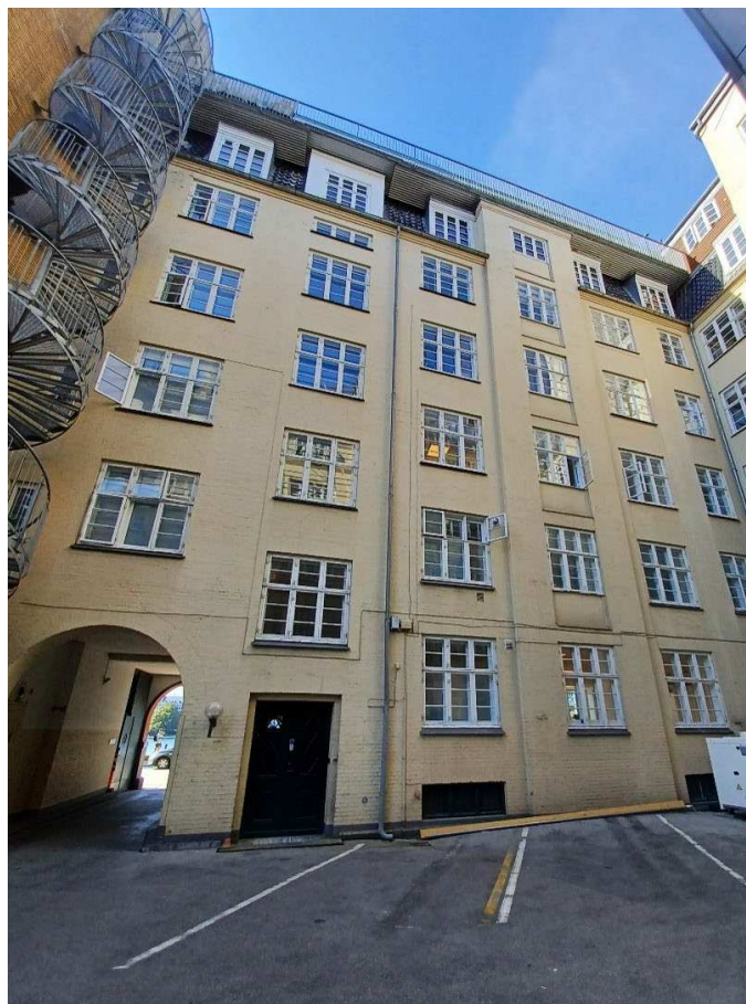
Forhusets facade set fra gårdrummet.
