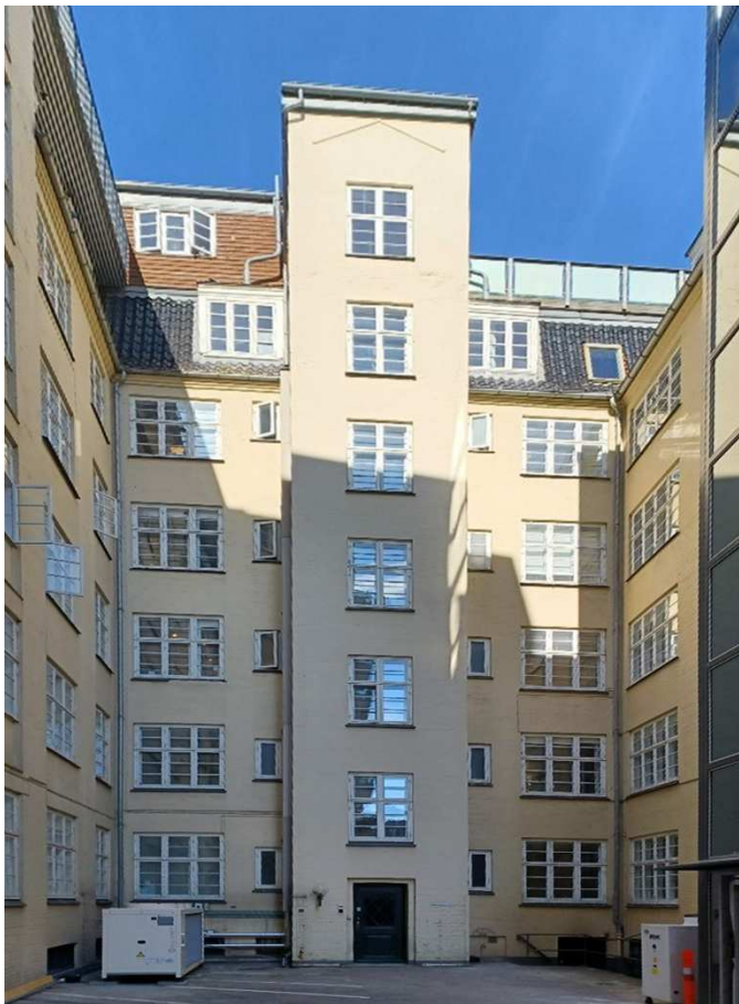
Mellemhusets facade set fra gårdrummet.
