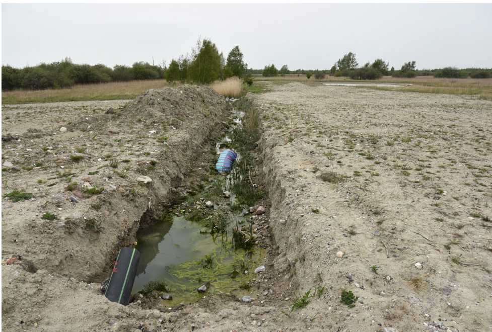
Figur 2 - Opfyldning ud for skolen i den sydlige del af området – Maj 2017. Grænsen mellem den påfyldte jord og den gamle overflade ses tydeligt i den gennemgravede grøft.
