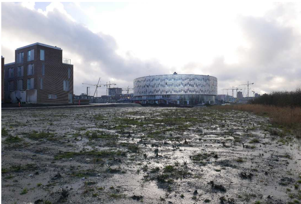
Figur 2 Terrænreguleringen set mod Kalvebod Fælled Skole.
