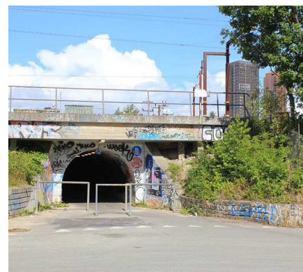
Indgangen til den vigtige stitunnel til Enghavevej set fra Otto Busses Vej. Opgradering af denne, eller etablering af en ny, vil være et vigtigt element i den fremtidige trafikbetjening af området. I baggrunden ses højhusene i Carlsbergbyen.
