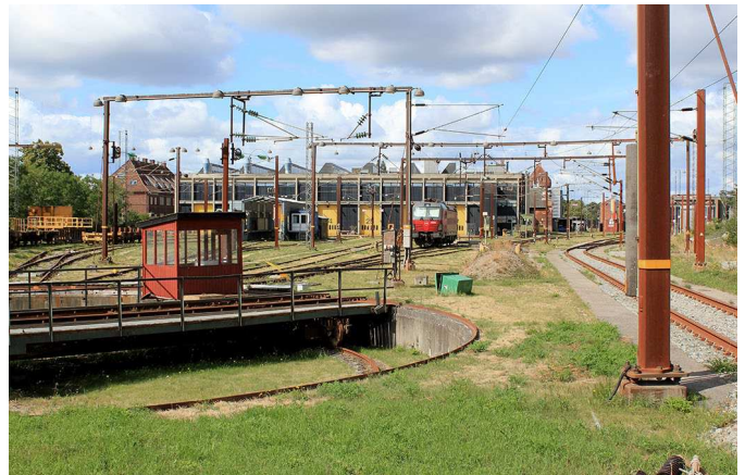
Drejeskiven er et af de bevaringsværdige tekniske anlæg, der er karakteristiske for området.
