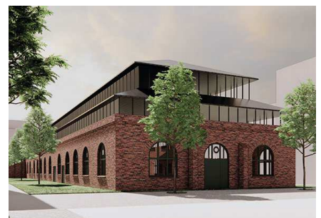
Eksempel på mulig udformning af påbygning på det bevaringsværdige blanketlager med valmtag og vinduesbånd i overensstemmelse med lokalplanens bestemmelser. Illustration: Team Cobe.
