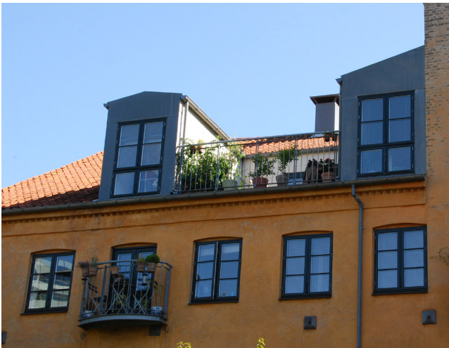
Foto 15. Eksempel på en altan som udskæring i taget mellem en kvist og en påbygning. Rækværk er holdt bag facadelinjen og er transparent.
