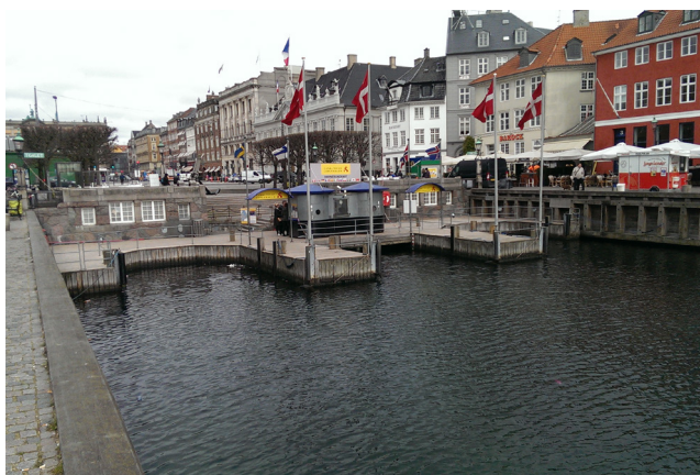
Landingspladsen med trappeanlægget, hvor der er påbygget en træbrygge med mulighed for 3 anløb.
