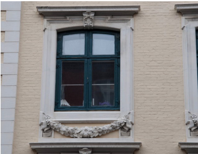
Foto 8. Flere huse i blankt murværk er blevet overmalede direkte på den blanke mur, så de nu fremstår som hverken pudsede eller i blank mur, som øvrige facader i området.
