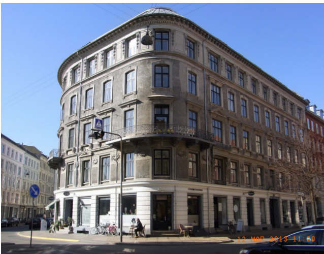
Foto 9. Facadedetaljeringen som dekorationer, gesimser og lignende skal opleves gennem forskellige materialer eller skyggevirkningen og ikke ved at fremhæve dekorationerne med en malerbehandling i anden farve.
