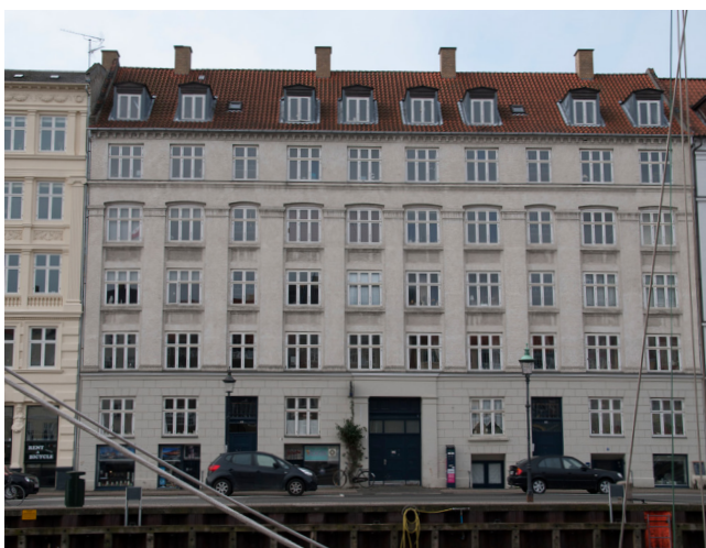
Foto 3. Et eksempel på en ejendom, som har karakteristiske skorstene, og som kan ses på lang afstand, hvor det ville forringe bygningens karakter og oplevelsen mod himlen, hvis skorstenene blev fjernet.
